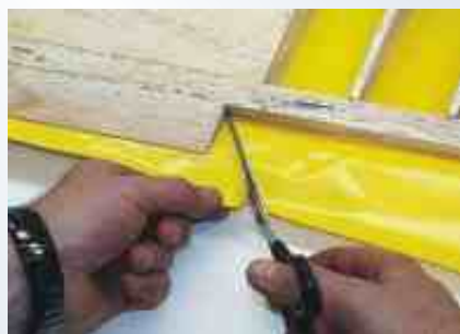
Fig. 12a Per angoli interni, piegare prima di 45°
